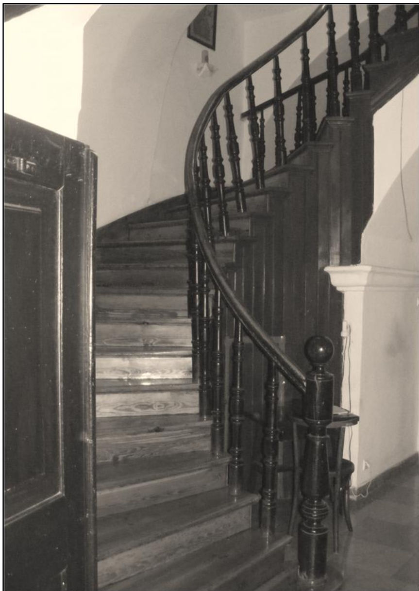
Schody wiodące do chóru i innych pomieszczeń pensjonatu.
